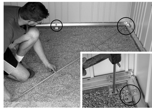
**3.** Füllen Sie den Boden noch mit ca. 1 bis 2 cm Schotter (Splitt) auf, sodass die Köpfe der Bodenanker zugedeckt sind. Ebnen Sie die Oberfläche wiederum waagrecht. Legen Sie nun die Bodenplatte(n) wie dargestellt ein. Die einzelnen Bodenplatten verbinden Sie wie abgebildet durch beidseitiges Einschieben in das Aluminium-Verbindungsprofil. Die Bodenplatten werden durch den Bodenrahmen allseitig eingefasst und brauchen nicht verschraubt werden.
