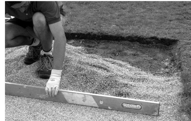
Füllen Sie die Grube mit feinem Schotter (Splitt) und ebnen Sie die Oberfläche waagrecht.
