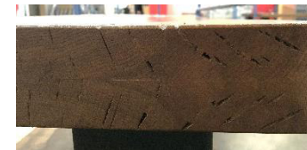
Risse an der Kante
